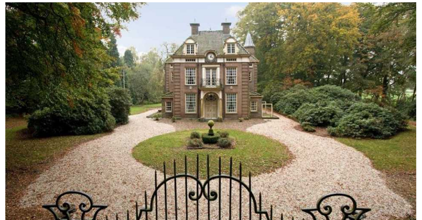
plein en gebouw horen bij elkaar
